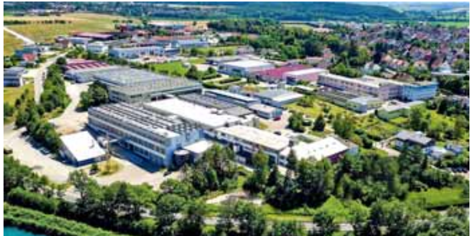
Das Betriebsgelände der TVU ist am Standort Leutershausen über die Jahre gewachsen.
